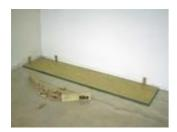
(2) In genauer Verlängerung zur ersten wird die zweite Diele eingehebelt. Neigen Sie dazu die Diele ca. 20°, führen Sie die Stirnfeder in die Stirnnut ein und senken Sie bei dichter Fuge die Diele ab. Leichter Druck erleichtert das Einhebeln. Mit einem leichten Schlag mit einer Verlegehilfe gegen das Stirnende der bereits liegenden Diele erreichen Sie den optimalen Fugenschluss.
