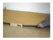
(6) Schieben Sie die noch geneigte Diele in die Längsnut. Ein leichtes Anheben erleichtert das Einschieben. Beim Einschieben die bereits geschlossene Stirnverbindung nicht mehr lösen. Schieben Sie deshalb in der Nähe der Stirnverbindung.
