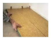
(7) Entfernen Sie bei dichter Längs- und Stirnfuge die Verlegehilfe und senken Sie die Dielen durch leichtes Klopfen mit der Verlegehilfe ab. Drücken Sie nicht einfach die Diele herunter! Sie unterstützen durch das leichte Klopfen den Formschluss der Uniclick-Verbindung. So erreichen Sie einen optimalen Fugenschluss.
