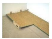
(5) Nächste Diele stirnseitig so einhebeln, dass zum Einschieben in die Längsverbindung nur noch ein geringer Weg bleibt.
