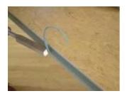
Der Boden ist nach der Verlegung sofort begehbar. Entfernen Sie dann die Keile. Schneiden Sie ringsherum die vorstehende Folie ab. Befestigen Sie Sockelleisten mit Nägeln oder Schrauben an der Wand, nie am Fußboden.
